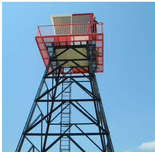
Figura 10.- Torre 2 situada en el extremo de la Línea de Falta más alejado de la entrada al Cuartel Militar.
